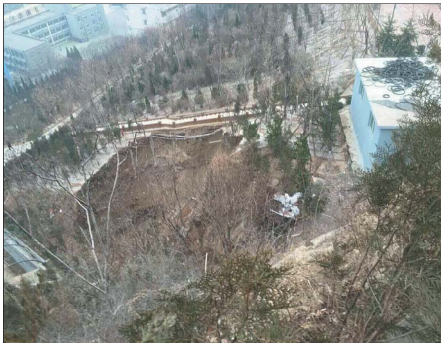
发生坍塌的地方在半山腰。 本报记者 时培磊 摄
