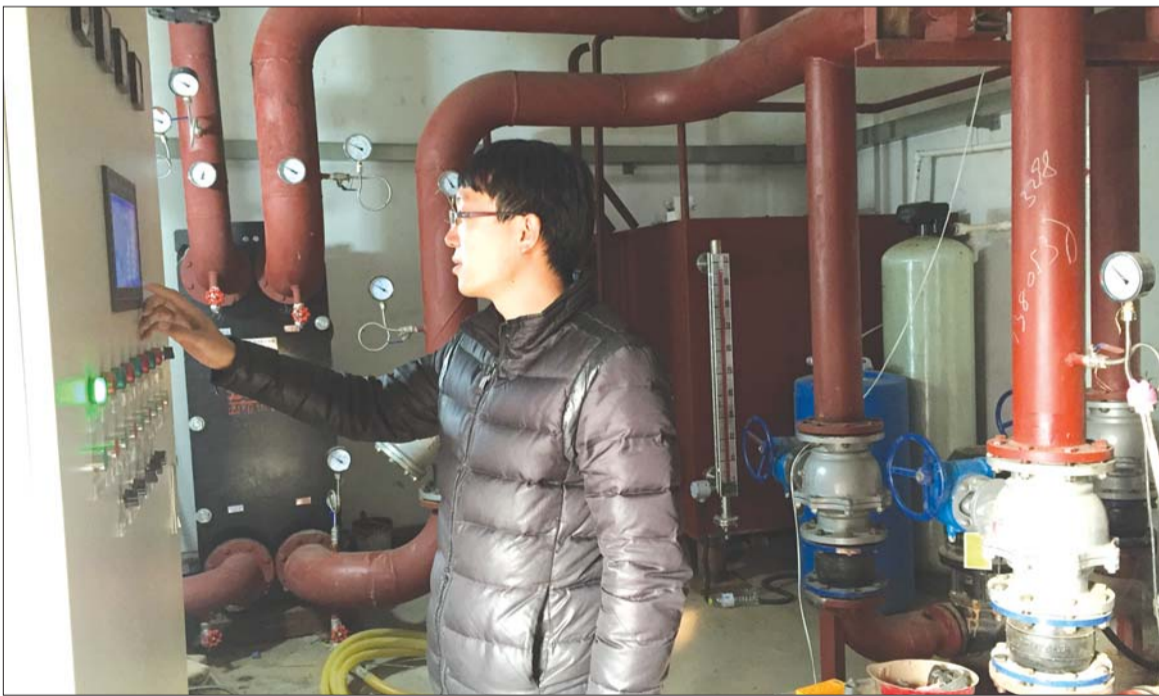
热力管道覆盖后,津浦南街小区刚刚建了新的换热站。本报记者 庄子帆 摄
