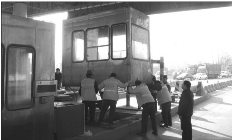
拆除收费岗亭。
