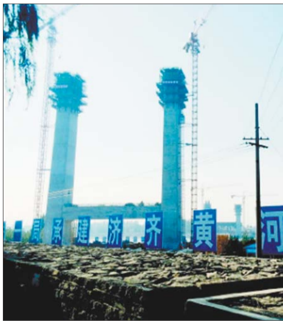
正在建设中的济齐黄河大桥。
