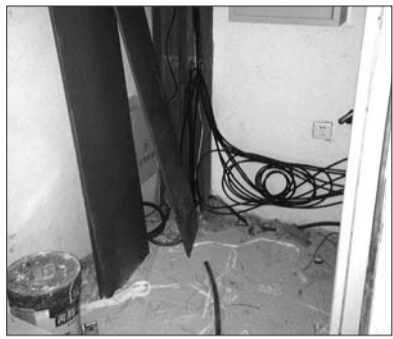
楼内设施没安装完。本报记者 陈新 摄
