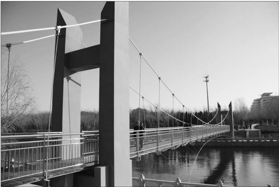
新建成的新立河吊桥成为一道靓丽的风景。(资料片)
