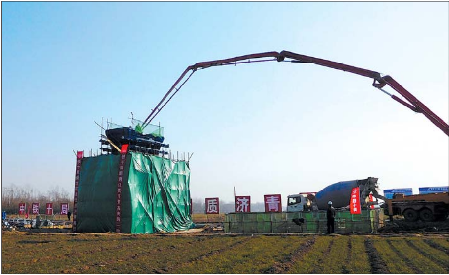
14日上午,济青高铁章丘段跨绣江河特大桥80号墩开始浇筑。 本报记者 宋磊 通讯员 肖熊 摄
