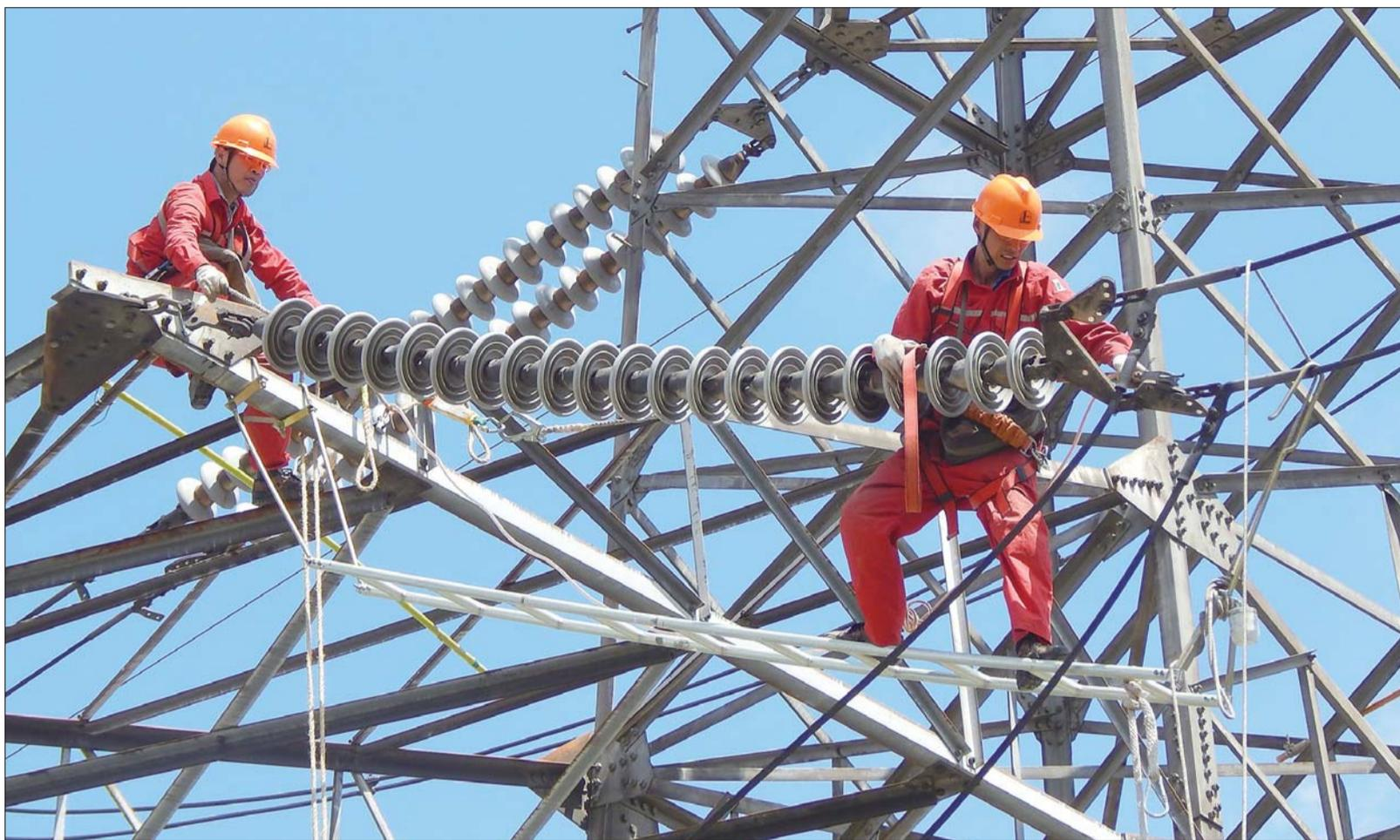
员工检修时应用研发的“导线接头大修挂梯”提高工作效率。 本报通讯员 赵晖 摄
