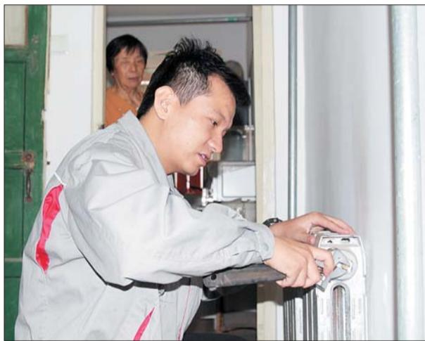
据悉,之所以将暖气阀门关小,这样操作之后,可以使暖气管道内水流通的速度加快,保证管道内有水循环,不至于出现低温时,暖气管道内出现“死水”结冰,暖气管道冻裂的情况。
