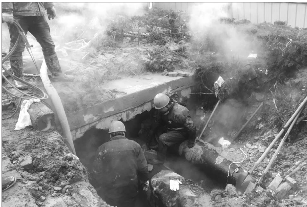
供热公司工作人员正在抢修供暖管道。 本报记者 张召旭 摄
