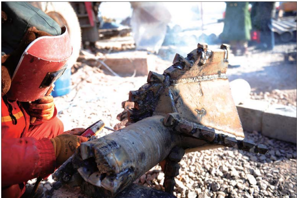
工作人员不断修复钻头。 本报记者 戴伟 摄
