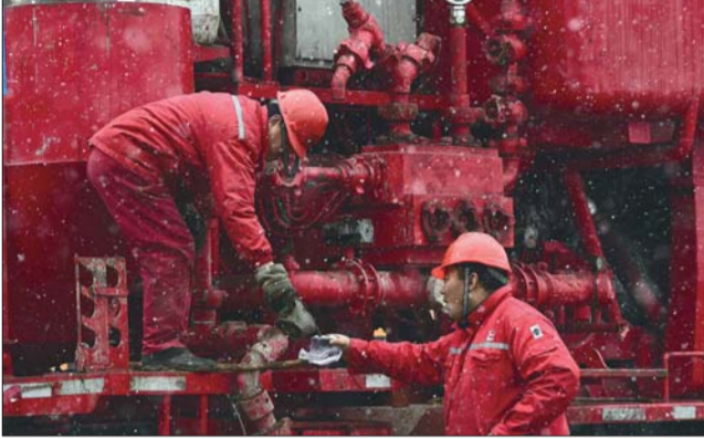
1月6日,救援人员在进行5号大口径救生钻孔环空封闭作业。据新华社
