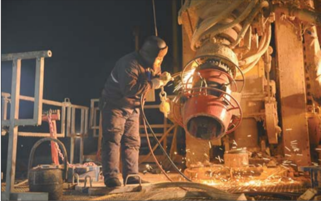
1月23日,救援人员根据不同岩层更换钻头。本报记者 戴伟 摄
