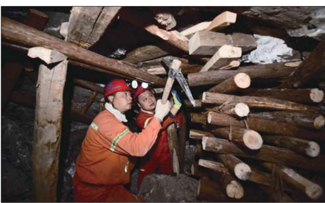
2015年12月27日,救援人员在300多米深处,打木垛以支撑坍塌巷道。据新华社
