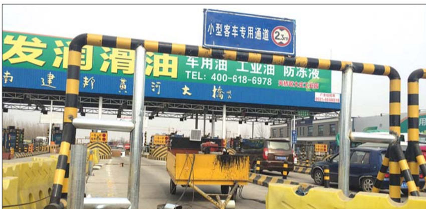
8日,济南建邦黄河大桥正在设置限宽通道。 本报记者 刘飞跃 摄
