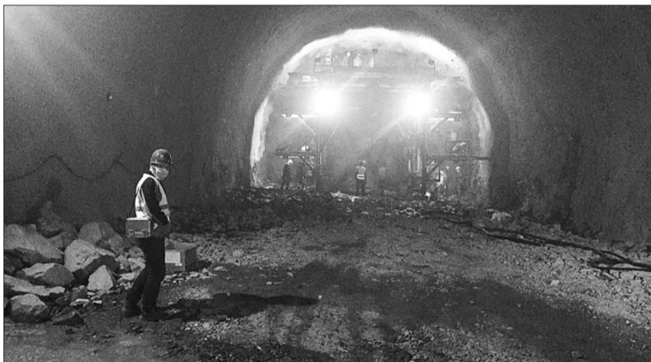
青岛地铁1号线作为国内首条跨海地铁,17日过海段已开挖200余米。 本报记者 赵波 摄
