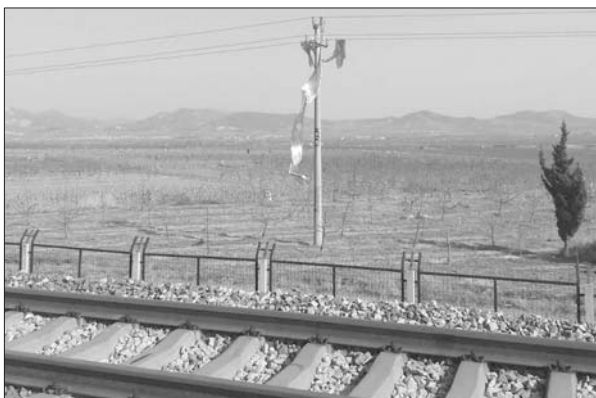
塑料反光膜被风刮到铁路电力接触线上造成短路事故。通讯员供图
