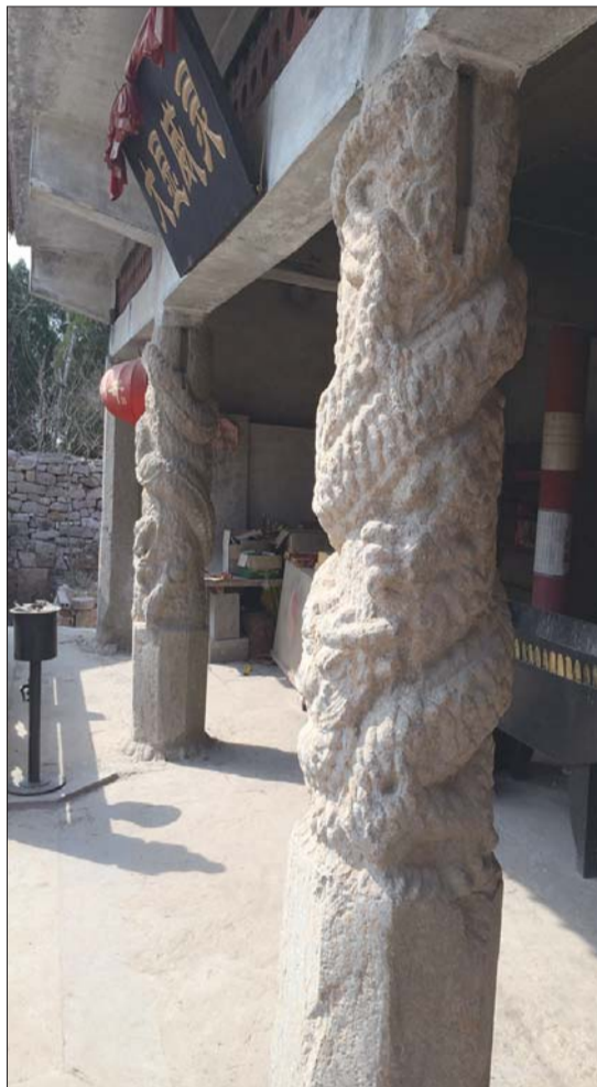
玉皇庙大殿前有两根浮雕盘龙石柱,两石柱各雕有一盘龙。
