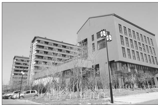
济南养老服务中心外观。
