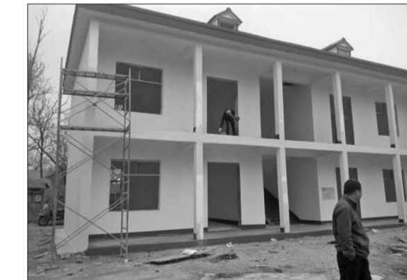
任光春发生的意外的办公楼接近完工。
