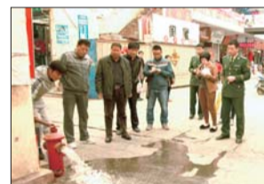
消防监督人员查看商城内消火栓供水水压。
