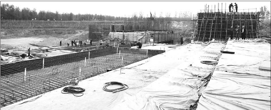
南跃进沟提水泵站正加紧施工。本报记者 黄广华 摄
