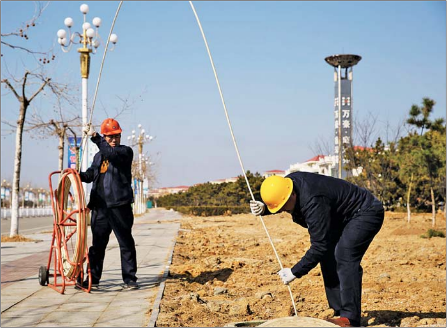
工作人员正在对银滩小区内老旧电缆进行双向光纤网改造。
