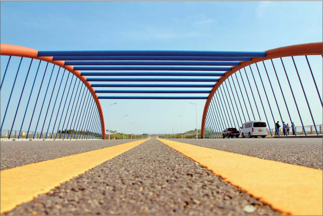
图为,乳山滨海新区内桥路设施。
