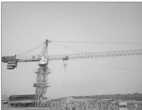
第一台塔吊安装完毕。
