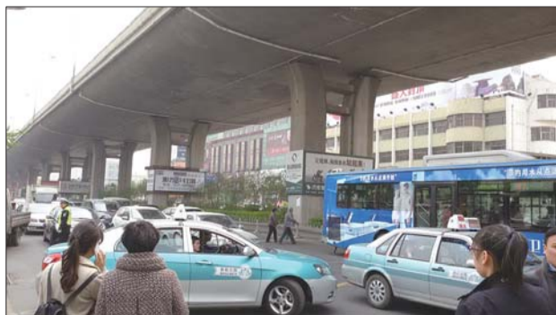
行人穿过车流、护栏等层层阻碍横过马路。 本报记者 张泰来 摄
