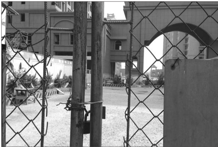
华天御园工地大门紧锁。
