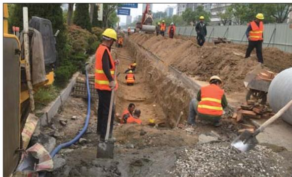
19日,施工人员正在东昌路上铺设新的雨水管道。
