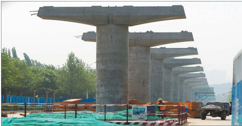
R1线海棠路园大段的成列墩柱。 本报记者 周青先 摄
