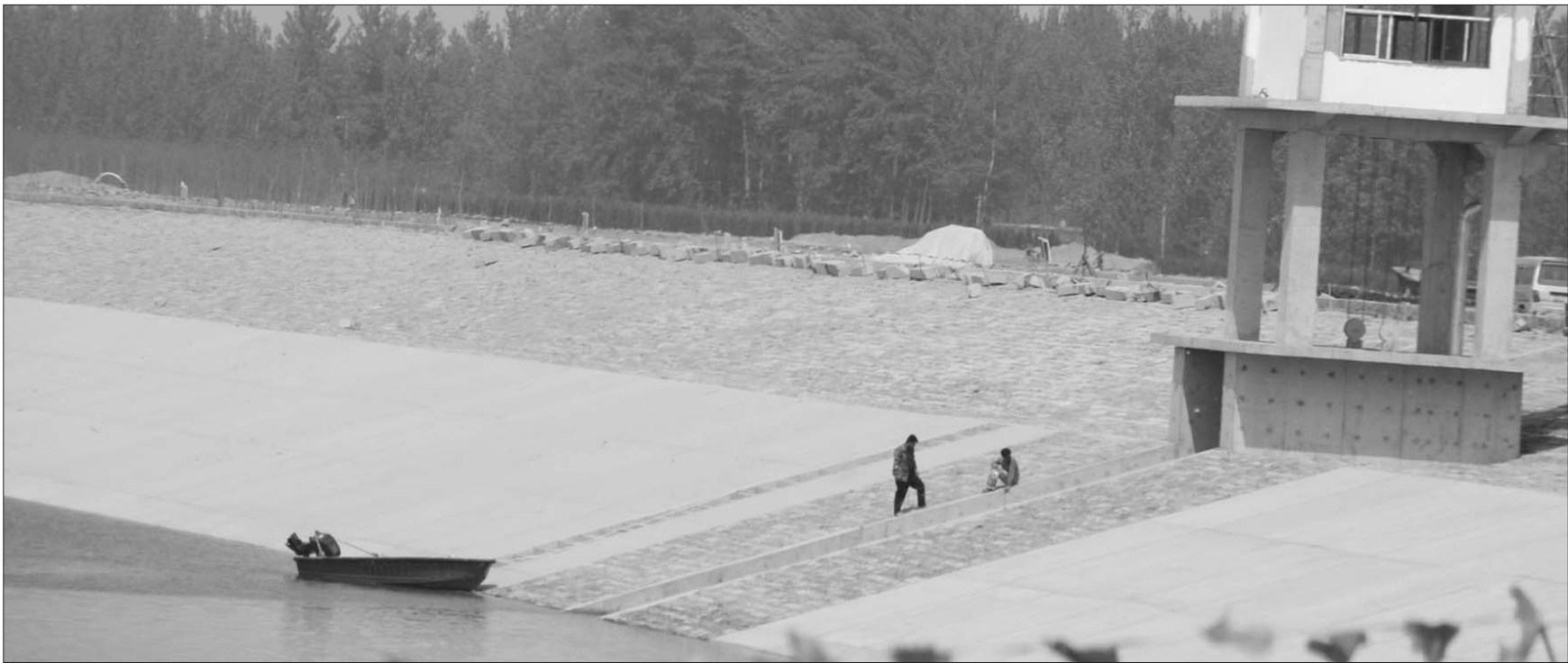
冠县冉海水库主体工程已完工,有望5月底前实现江水入库。
