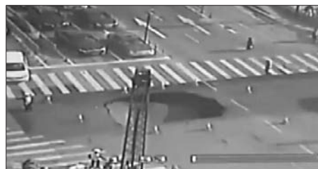
路面塌陷时,隔离帽已经摆放完毕。
