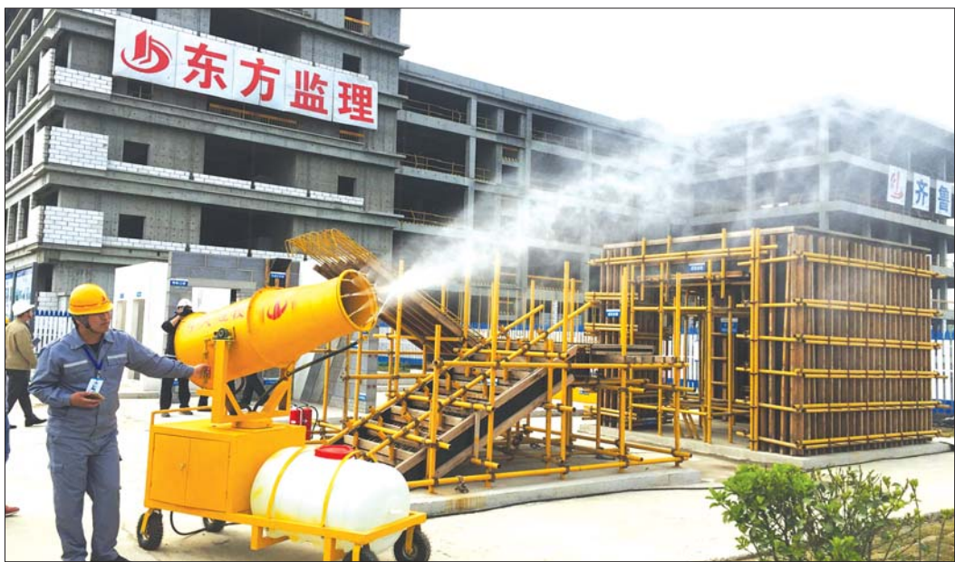
济宁市中医院新院区施工现场,配置防雾炮抑制扬尘。本报记者 庄子帆 摄
