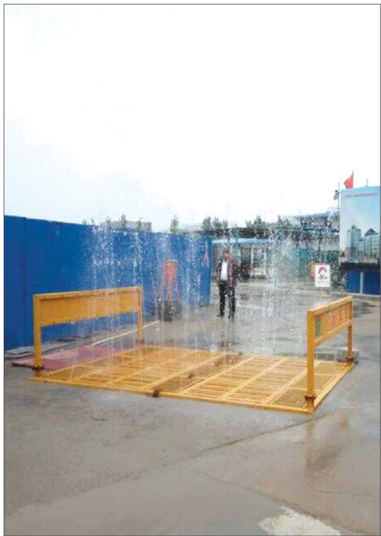
一在建项目工地增设喷淋设施。
