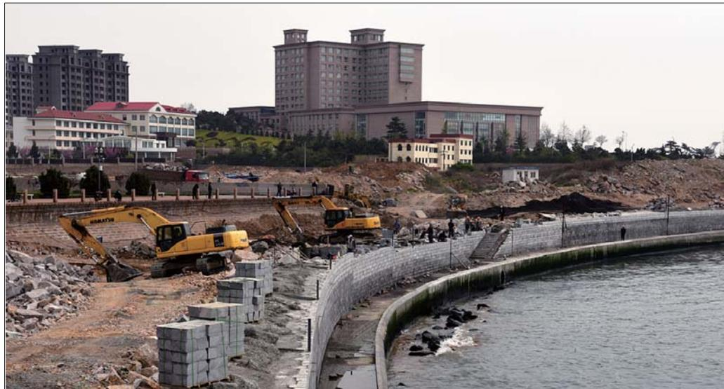
连日来,在亲海公园改扩建工程的施工现场,大型机械正在平整海岸路面,防浪堤修建工程正加快推进。该项目是管理区今年重点实施的城建工程,共需修建防浪堤130米,改造铺装人行道板6500平方米,修建排水暗沟40米,安装污水管道170米。目前,工程正按部就班推进,已铺贴镶面石约220立方米。
