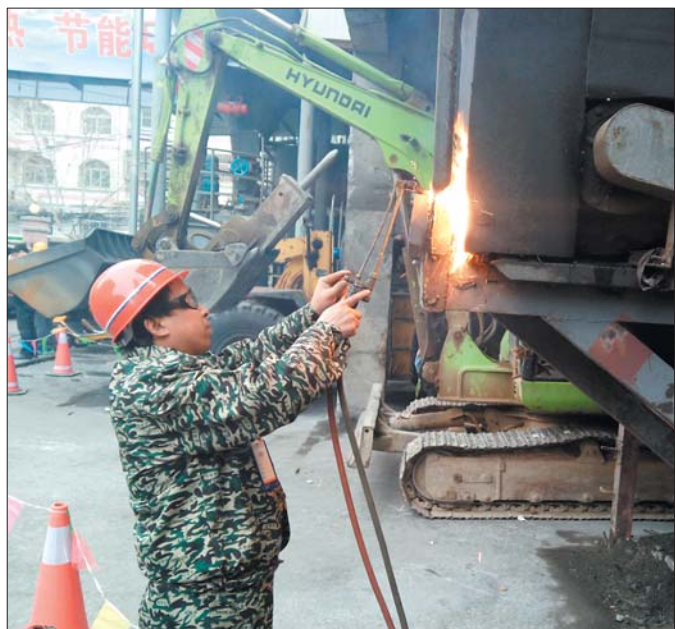
工作人员正在拆除燃煤锅炉房。本报记者 蒋龙龙 摄
