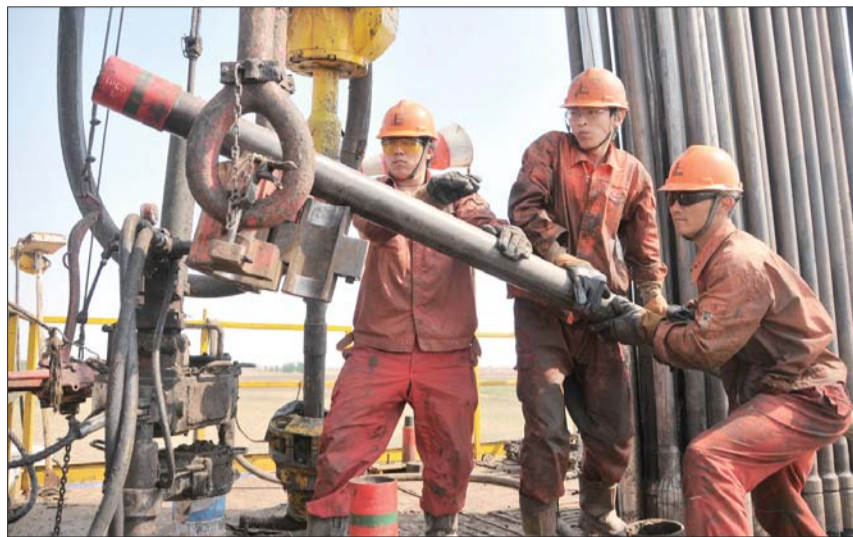
作业施工现场。
