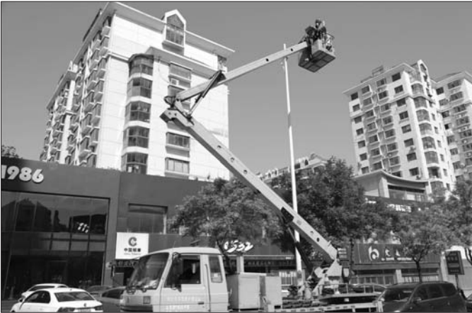
路灯维修工人站在高空作业车上更换LED新灯头。 通讯员供图
