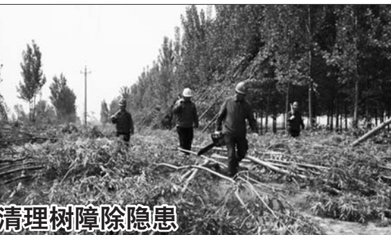
清理树障除隐患 5月11日,国网乐陵市供电公司胡家供电所在积极做好各项前期工作的基础上,对10千伏西段线张店村线下树障进行集中清理。在与事关群众充分沟通后,胡家供电所全员出动,按期对该村树障进行集中清理,半天时间共清除树障2000余棵,及时消除了线路安全运行隐患。 本报通讯员 高有联 摄
