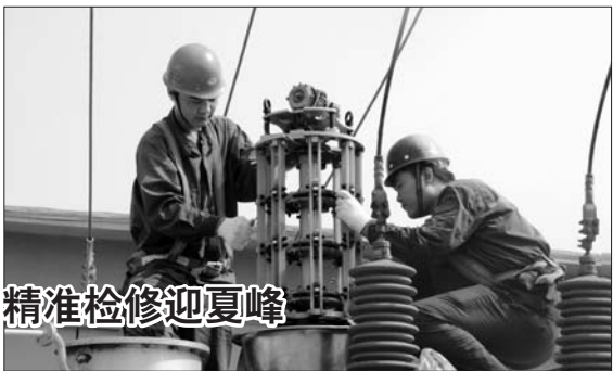
精准检修迎夏峰 5月17日,国网乐陵市供电公司对35千伏北郊变电站进行高压开关维护检修。变电检修人员对调压开关动、静触头进行解体检查,更换高压开关变压器油,测量绕组电阻,为变压器高压开关动作正常输出合格电压、正常承载夏季高压负荷打好了基础。 本报通讯员 李月 摄
