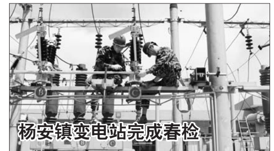
杨安镇变电站完成春检 5月10日,国网山东乐陵市供电公司变电检修班人员对35千伏杨安镇变电站进行检修。35千伏杨安镇变电站设备检修主要任务包括检查设备动定触头烧损情况、触头连接带是否紧固、开关油室密封状况等15项重点工作,本次检修共消除设备缺陷隐患23处,为变电站安全稳定运行提供了可靠保障。 本报通讯员 李月 摄
