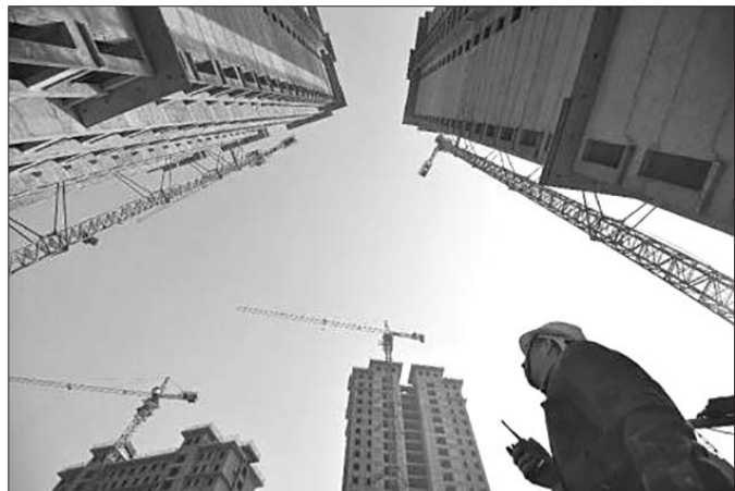
日照一个城中村改造安置项目正进行施工。(资料片)
