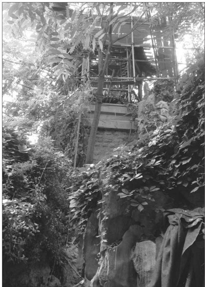
正在改造的五莲轩。 本报记者 唐园园 摄
