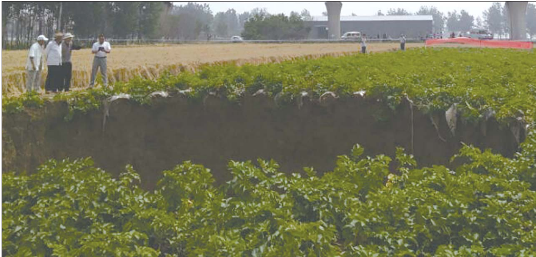
塌陷坑周围已拉上了警戒线,并有专人值守。本报记者 甘倩茹 摄
