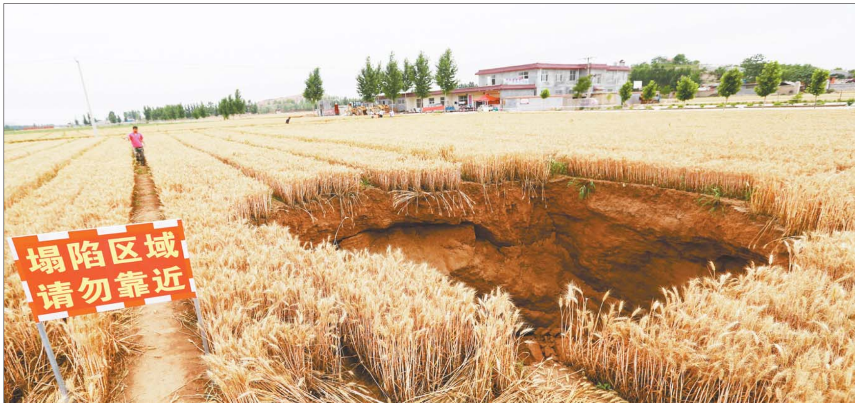
麦田里“天坑”旁设立了警示牌。 本报记者 黄广华 摄
