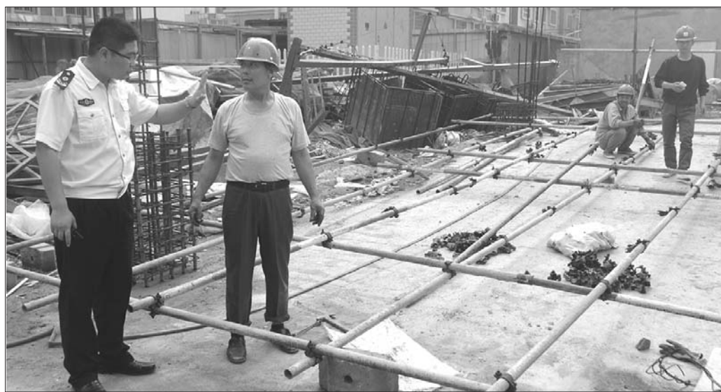
执法队员叫停一处施工作业。本报记者 苏洪印 摄
