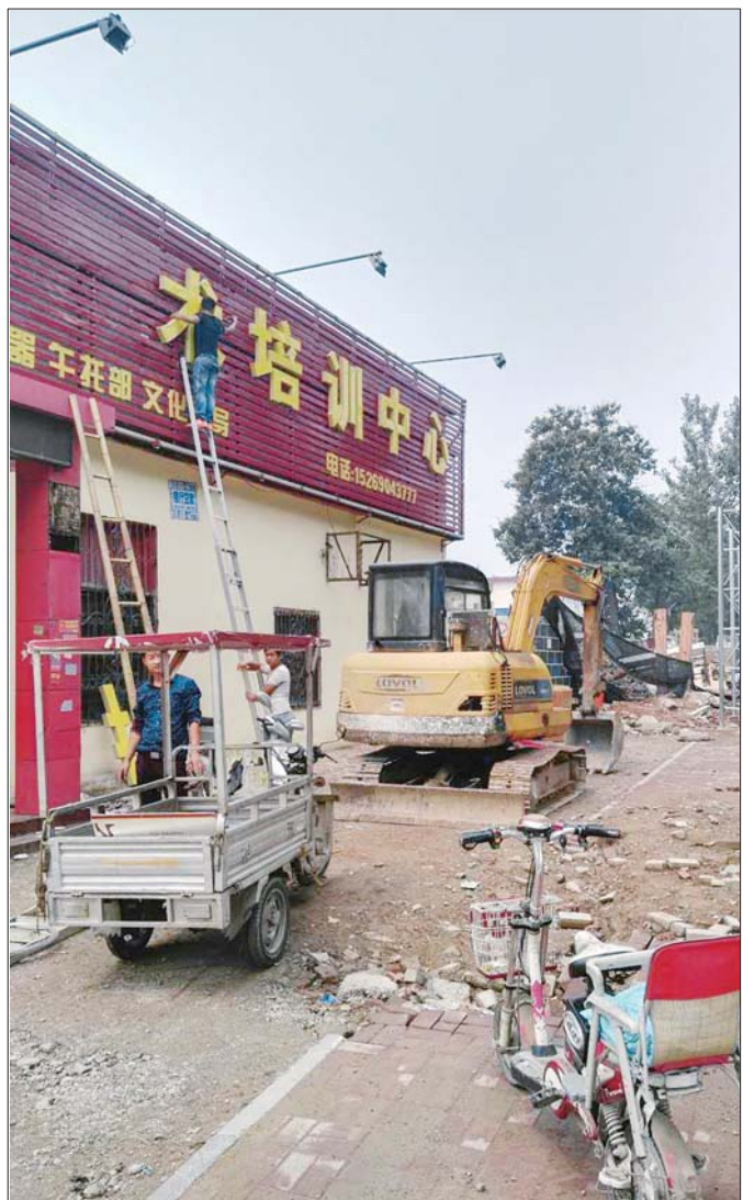
正在拆迁中的菏泽棚改片区。受访者供图
