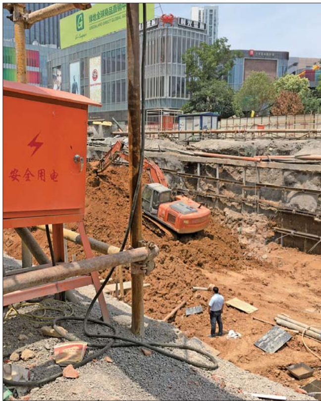
共青团路人防正在紧张施工,2个月后路面就能恢复。
