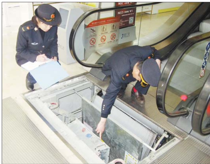
质监部门对商超电梯进行检查。
