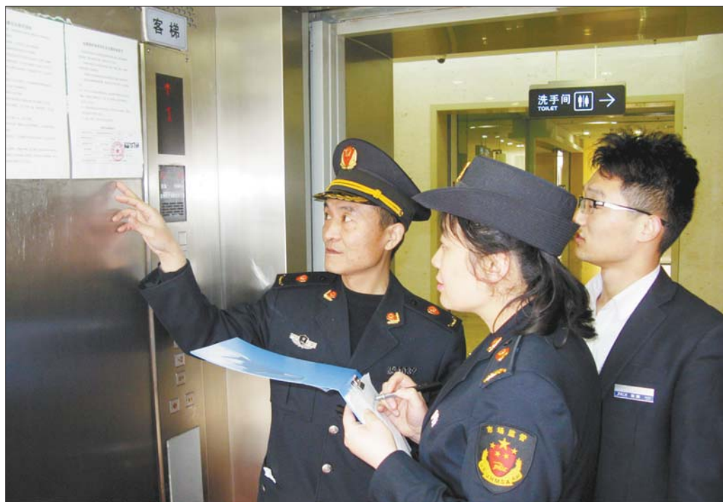
质监执法人员对电梯设备进行检查登记。
