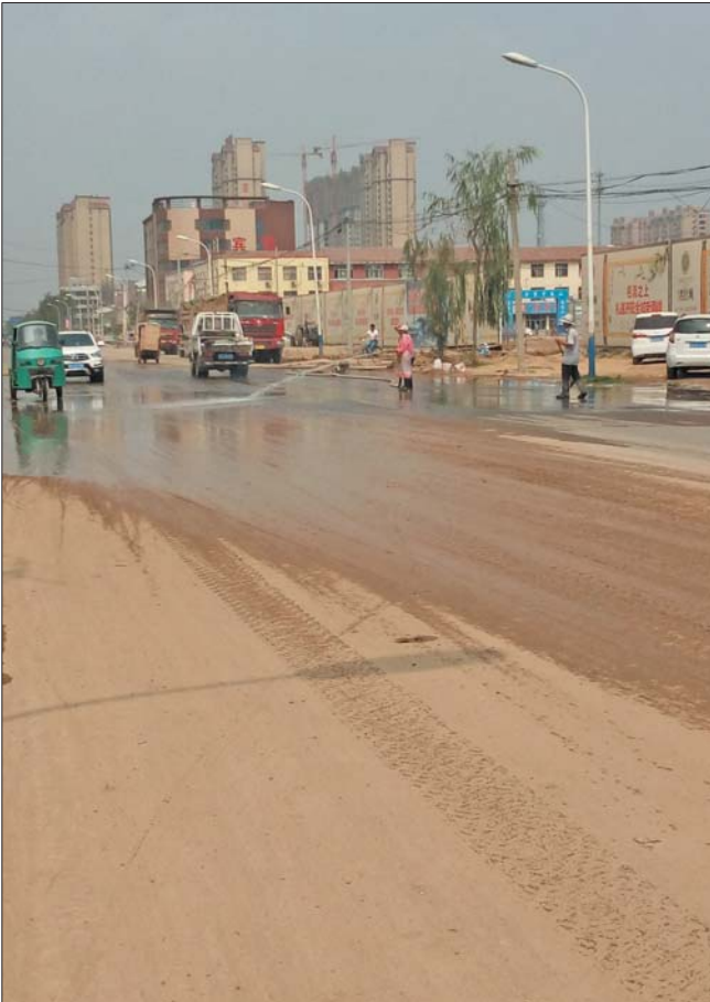
路面被尘土覆盖，工人进行洒水降尘。
