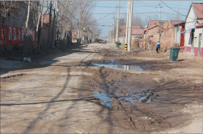
桥王路旧路,坑洼并有积水。
