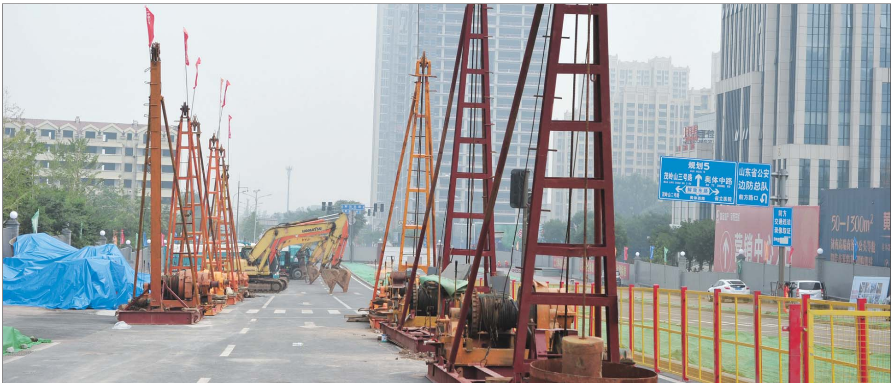
20日,济南轨道交通R3线奥体西路站施工现场。本报记者 周青先 摄
