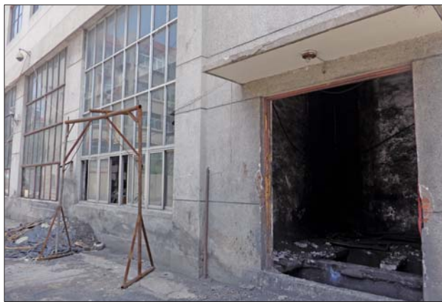
被拆除的山工艺锅炉房。 本报记者 孟燕 摄
