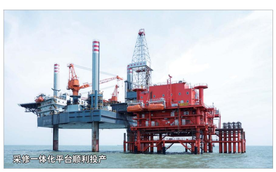
近日,随着胜利油田海洋采油厂CB6G采修一体化平台投产试运行,标志着该厂今年16.5万吨新井原油配产任务拉开序幕。据了解,新建40井式的CB6G采修一体化平台是胜利海上油田新建产能重要阵地,平台井口区共设计油井23口、注水井9口,预留井位8口。平台投产后,所产油气经平台加热计量,通过海底输油管线输送至CB6B平台,最终进入中心三号平台处理外输。截至目前,海洋厂已对达到生产条件的14口油井实施开井,日液量938吨,日油416吨。 本报记者 顾松 通讯员 张海彬 摄影报道
