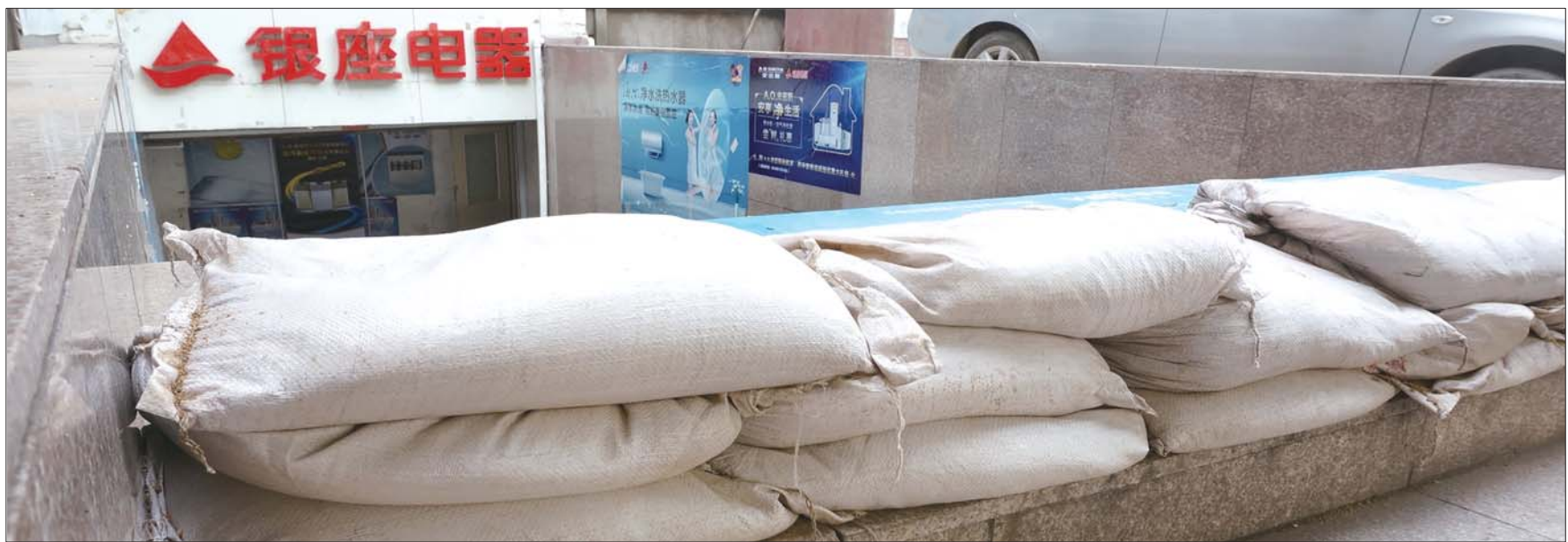
19日,因暴雨预警,济南泺源大街一商场地下入口,已筑起三层沙包防水。 本报记者 徐延春 摄
