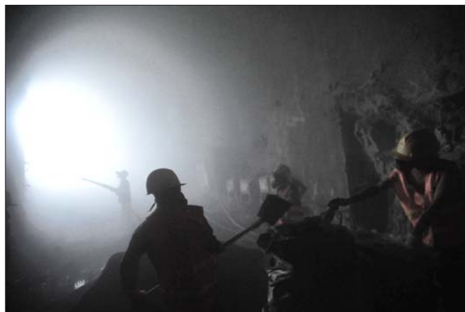
顺河高架南延隧道施工。本报记者 戴伟 摄
