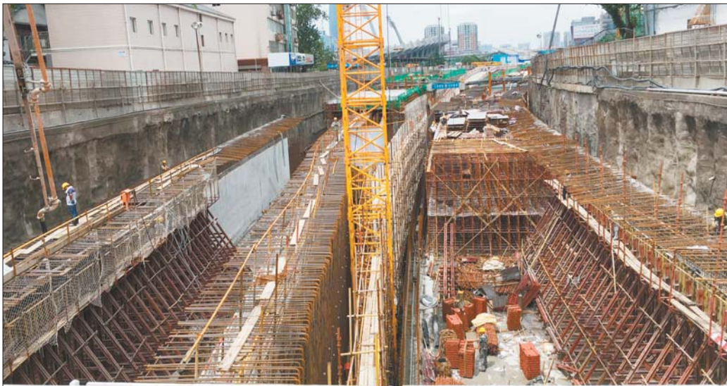
顺河高架南延明挖段施工。本报记者 王皇 摄
