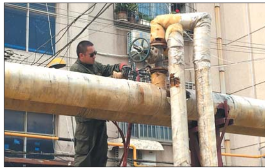
维修人员正在检修小区内的供热管线。
